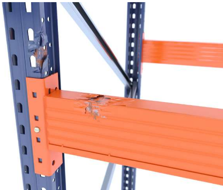
Montant et lisse endommagés par détérioration de la peinture
