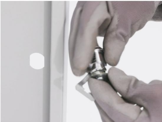
Separamos ambas partes de la cerradura para introducir el cilindro por el agujero central de la puerta.
