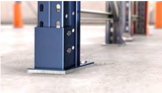
Placas de nivelación correctamente posicionadas
