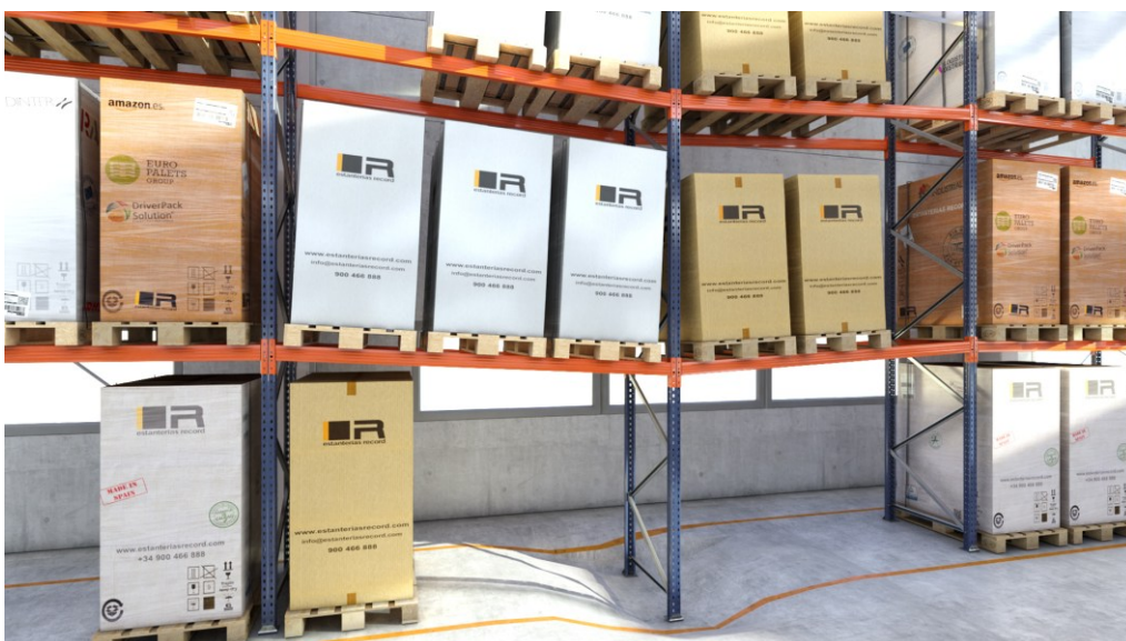
Risque critique d'effondrement de la structure par tassement du sol sous une échelle
